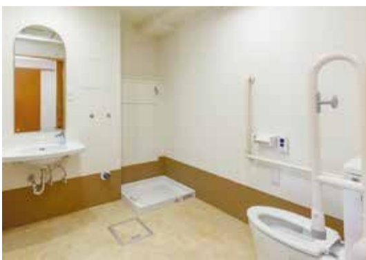
市営住宅での車いす対応のトイレ・洗面所
