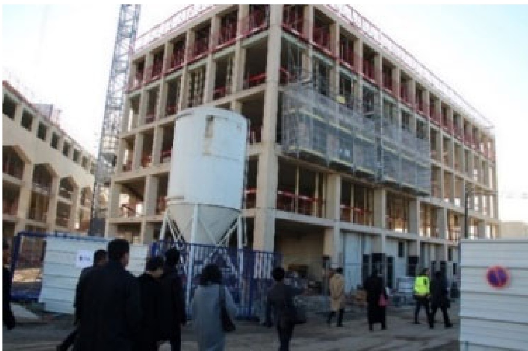
認証を受けた木造のオフィスビル（建築中）
