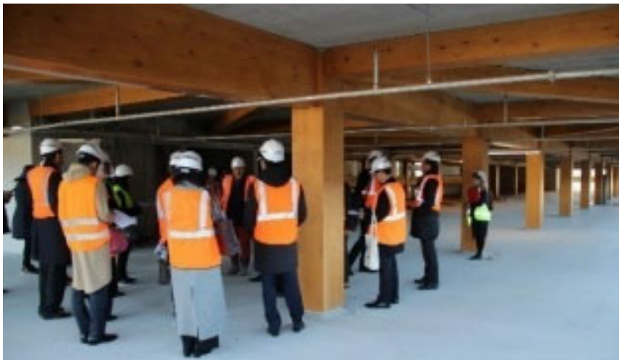
認証を受けた木造の立体駐車場（建築中）
