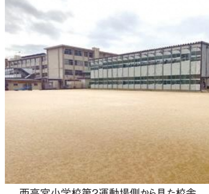
西高宮小学校第2運動場側から見た校舎
