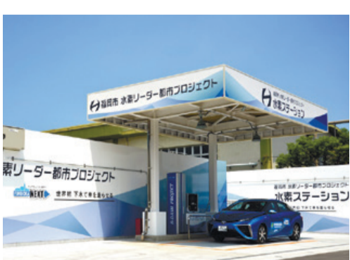
生活排水から水素を製造し、燃料電池自動車等へ供給する水素ステーション
