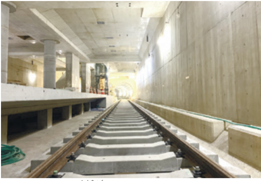
工事の進捗状況<中間駅(仮称)>
