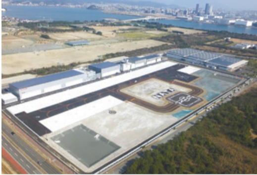
令和2年3月に供用開始された奈多へりポート
