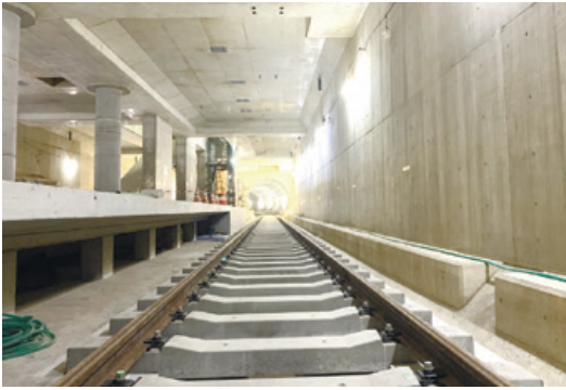
新幹線 工事の進捗状況<中間駅(仮称)>
