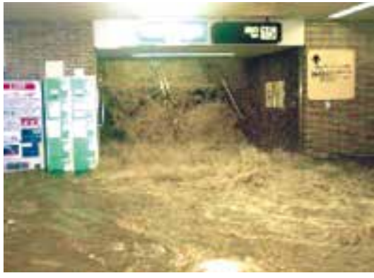
地下施設の浸水(平成15年7月水害)
