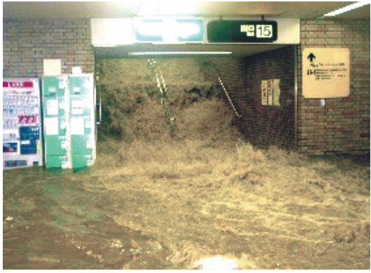
地下施設の浸水(平成15年7月水害)
