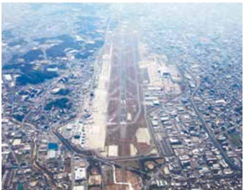
平成31年4月に民営化された福岡空港
