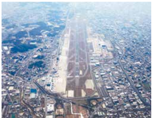
平成31年4月に民営化された福岡空港
