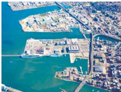
再整備が進められるウォーターフロント地区
